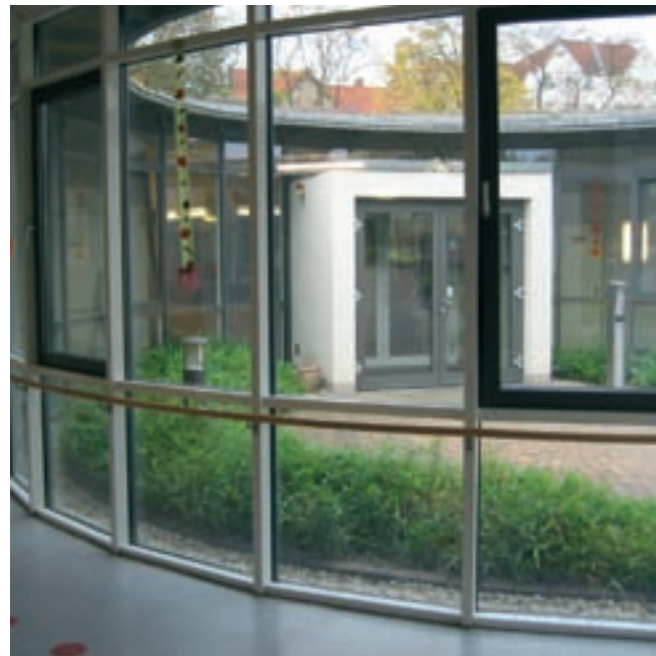
Hausgemeinschaft Demenz, Halle
